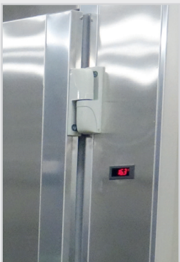
Afficheur de température côté sortie du tunnel
